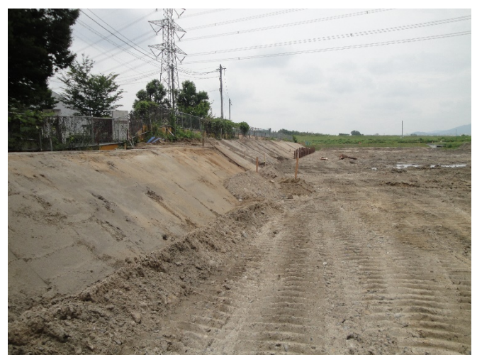
守山高校側（西側）のり面部分の状況
